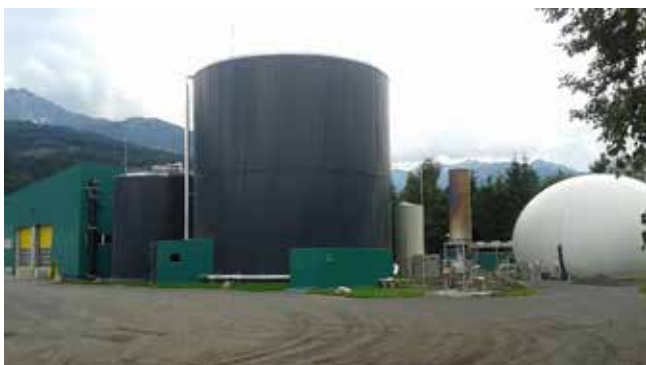
Impianto di Zell am See in Austria. Avviato nel 2013, tratta 18.000 ta di FORSU, rifiuti commerciali e fanghi.
