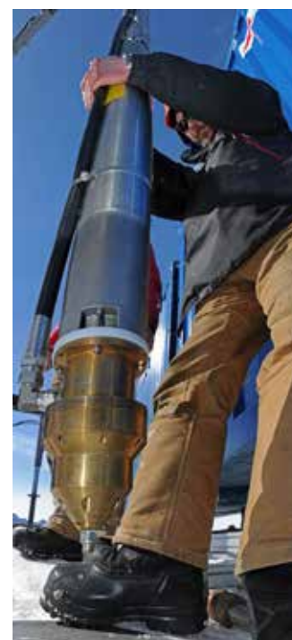
Durante l'operazione di trivellazione sono state utilizzate elettropompe Caprari.
