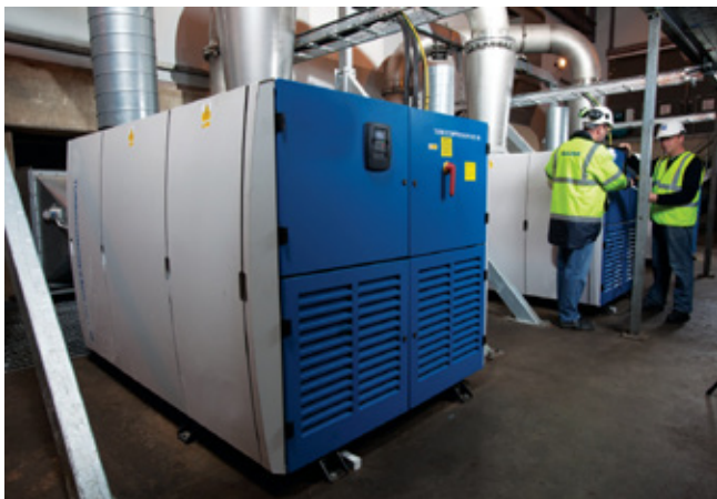
Figura 1 - Installazione di un turbocompressore HST.
