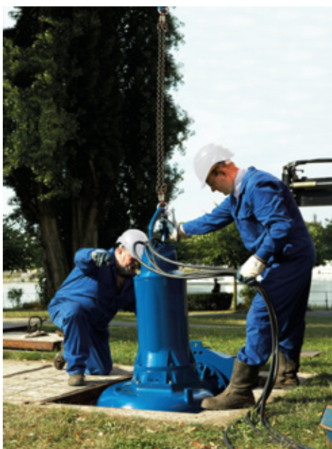
Figura 2 - Installazione di una pompa XFP.
